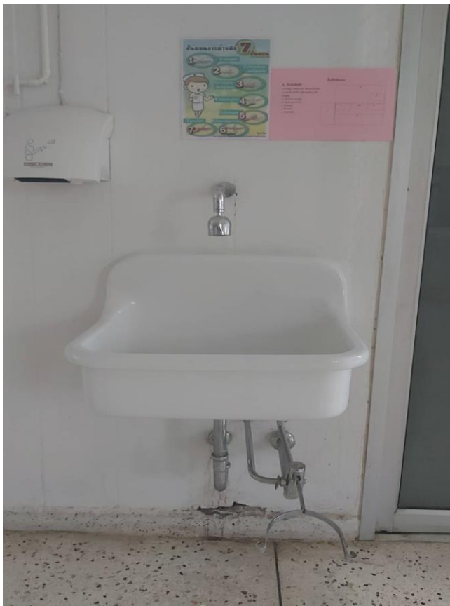
8) อ่างฟอกมือชนิดที่ไม่ใช้มือเปิดปิดน้ำ
