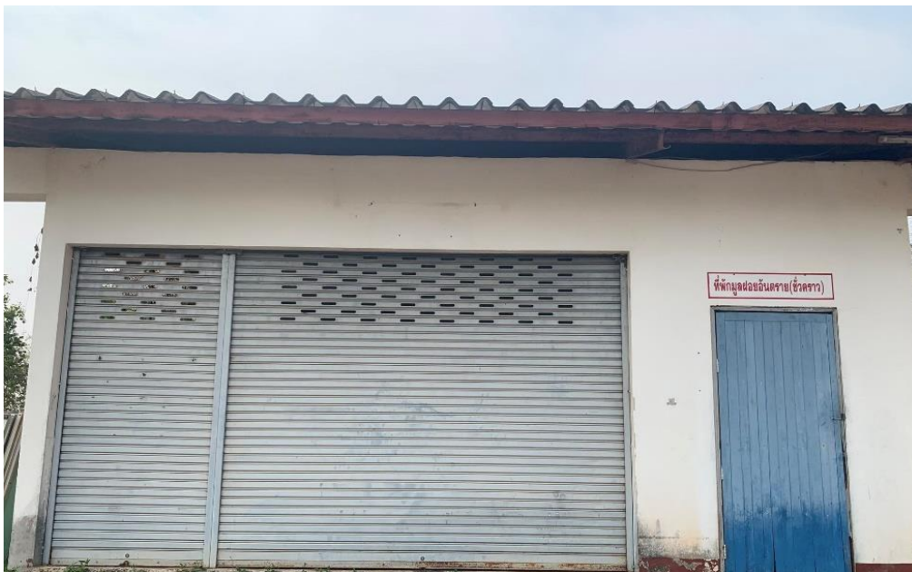
ที่พักรวมมูลฝอยอันตราย
