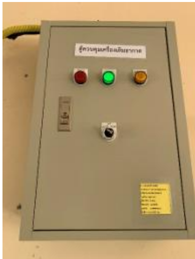
ตู้ควบคุมเครื่องเติมอากาศ
